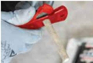
Snij de Stick op maat (=boordiepte - 0,5 cm)
