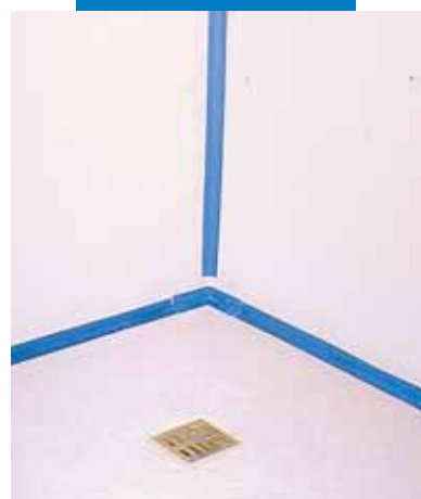
Waterdicht met Mapegum WPS en Mapeband
