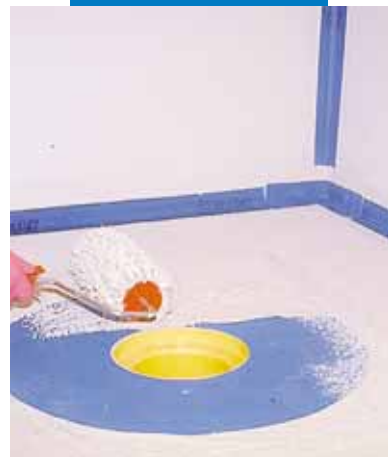
Aanbrengen van een speciaal Mapeband-afdichtstuk in natte Mapegum WPS
