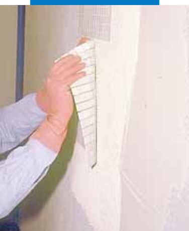
Aanbrengen van glasmozaïek
