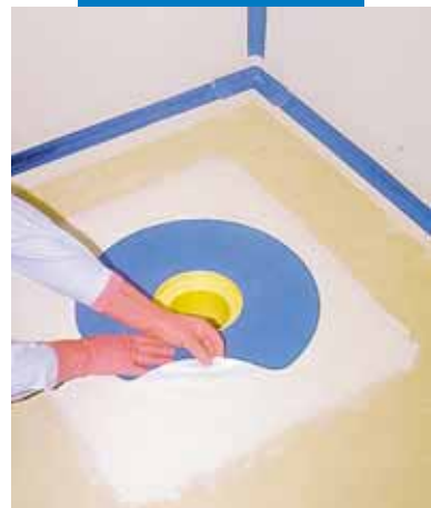
Aanbrengen van een speciaal Mapeband-afdichtstuk op Mapegum WPS
